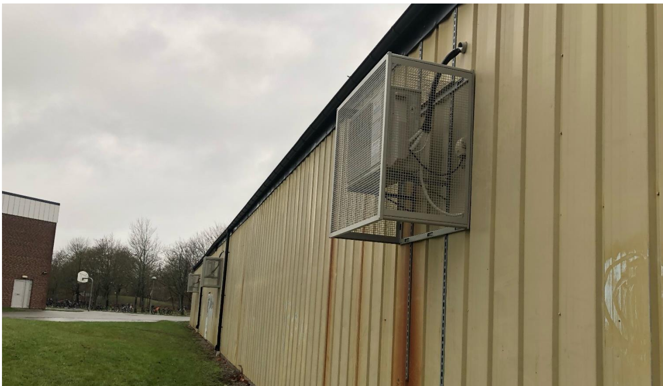
De tre värmepumparna som sitter mot skolan.
