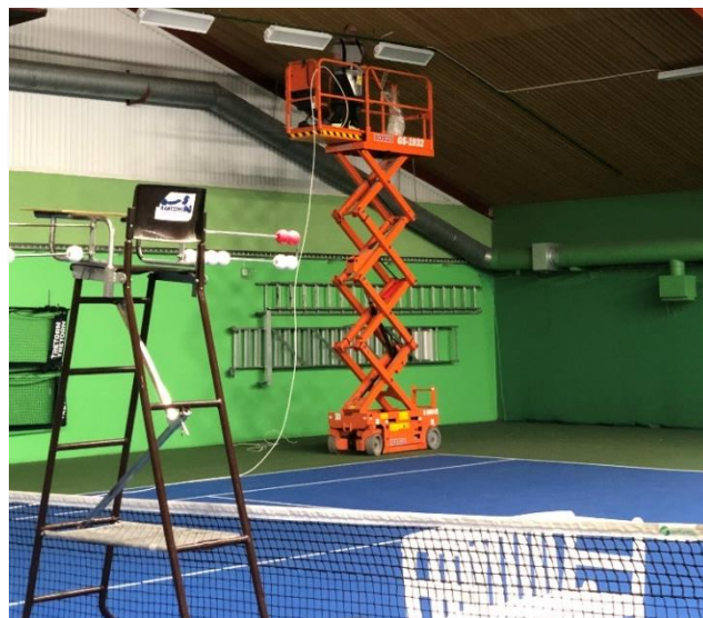
Bana 1 under arbete med bytet.
