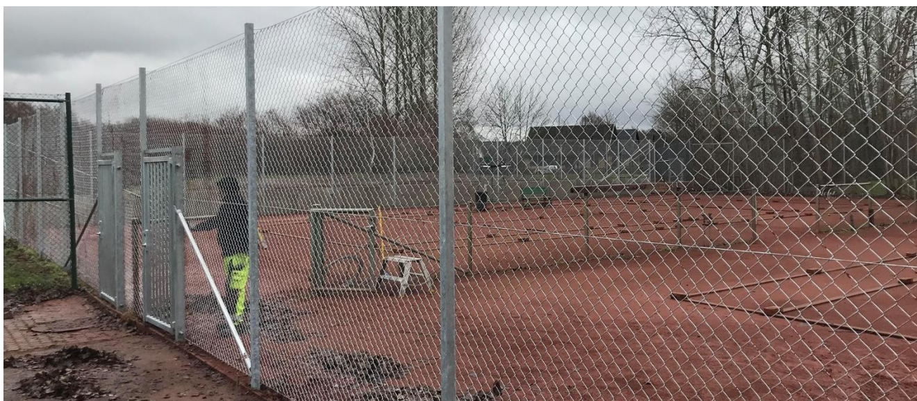
Nytt staket kring bana 1 och 2 kom på plats under januari.
